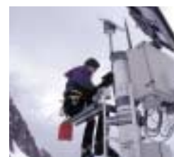
Maintenance d'une station Nivôse dans les Alpes.
